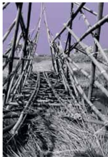
Diese Bambusbrücke errichteten Schüler des Ammersee-Gymnasiums über einen Bach am Lido in Venedig.
